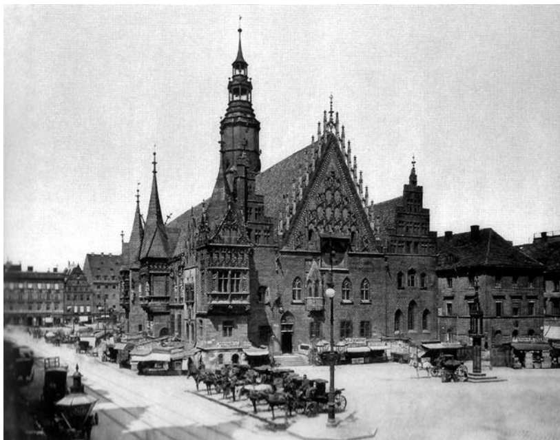
Das Breslauer Rathaus nach Renovierungs- und Konservierungsarbeiten um 1893
